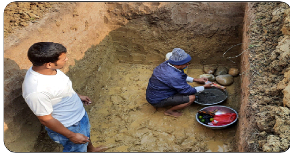
पालेघर निर्माण सिलन्यास
