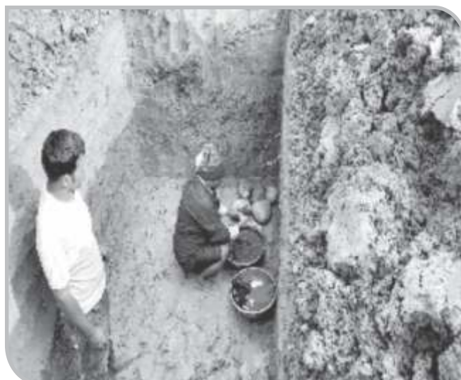
पालेघर निर्माण सिलन्यास
